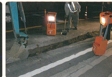
屋外の夜間工事現場の照明
