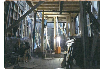
夜間の工事現場の照明
