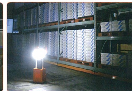
停電時倉庫の照明
